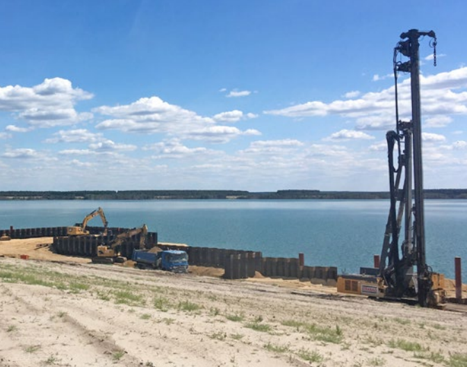
Maßnahmen zur Uferstabilisierung eines Bergbaufolgesees im Rahmen der Sanierung von ehemaligen Tagebauen.
