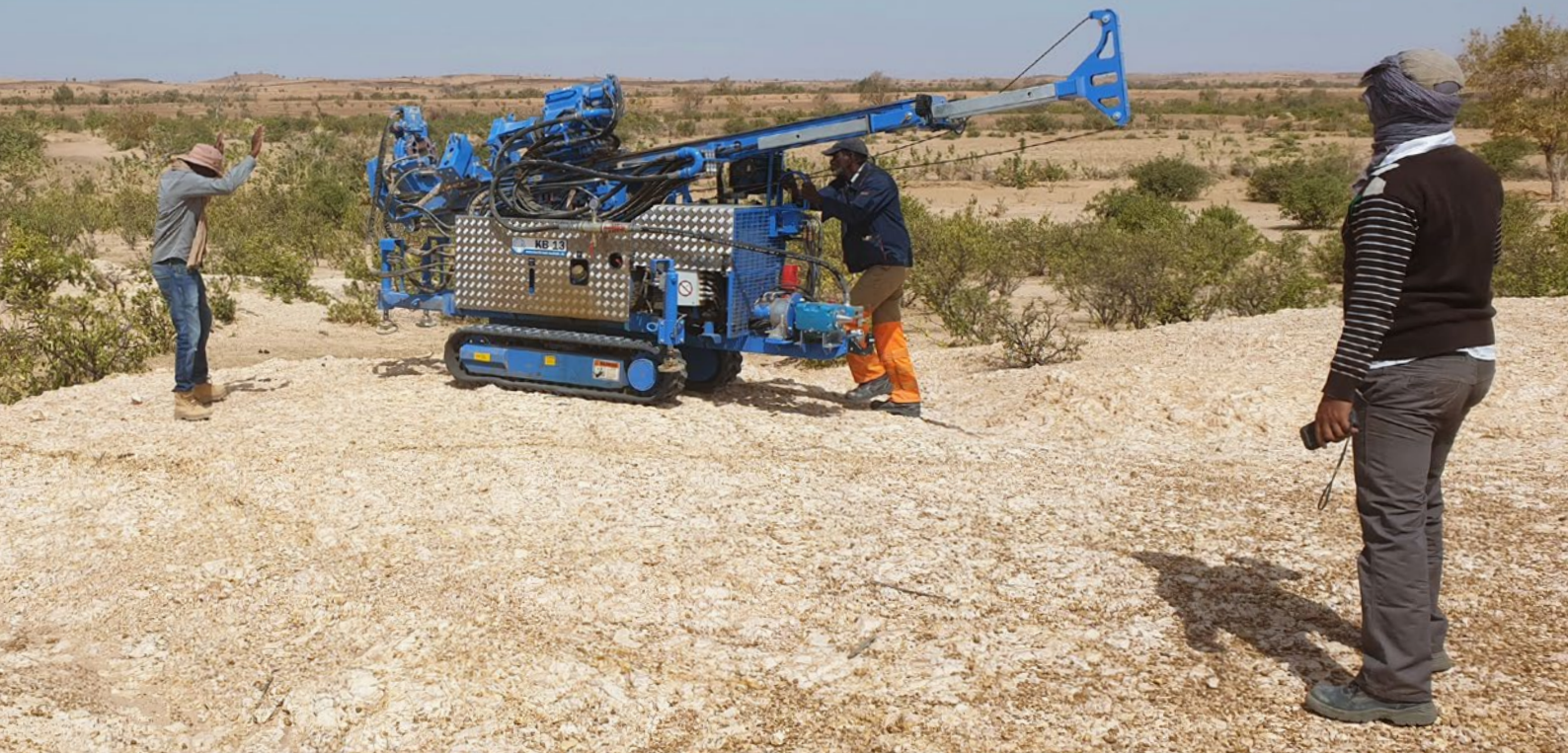
Vorbereitung der Bohrungen zur Erkundung des Kaolinvorkommens bei Hassi Abyad in Mauretanien.
